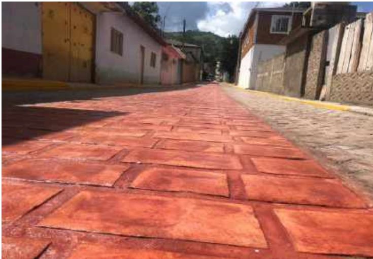
Imagen 34: Calle pavimentada en la cabecera Municipal
