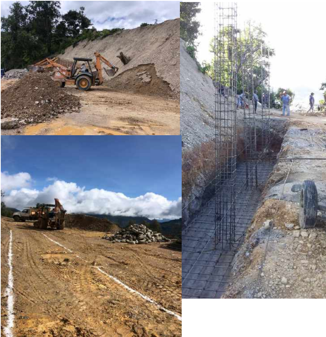
Imagen 39: Construcción de muro de contención en la comunidad de Yucuyí
