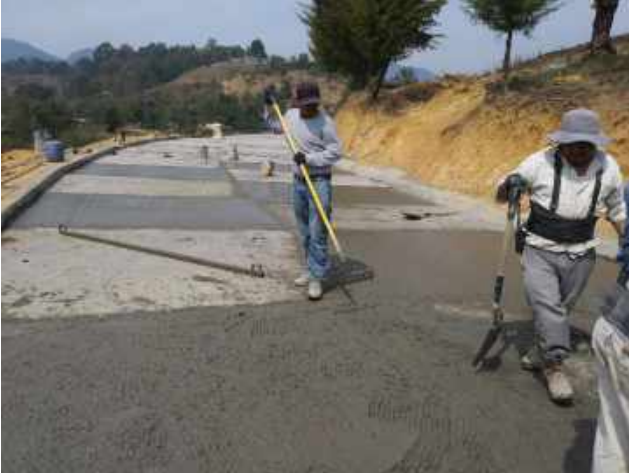
Imagen 35: Trabajos de pavimentación
