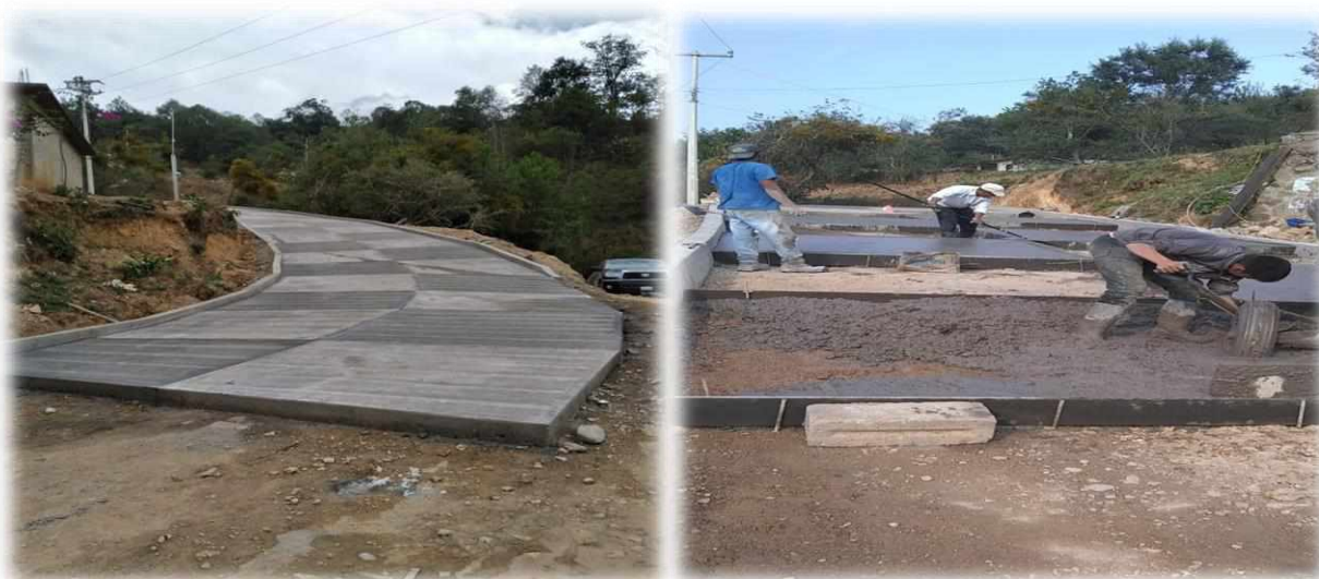
Imagen 37: Pavimentación de caminos rurales
