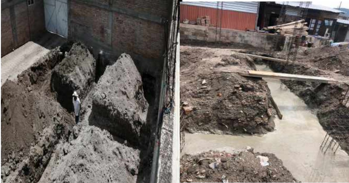
Imagen 23: Construcción de aulas para cocina en la cabecera Municipal
