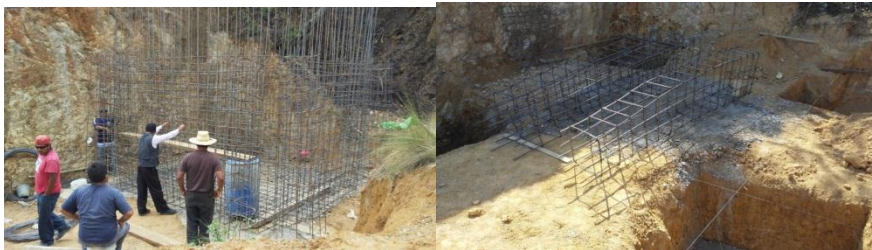
FOTO: OBRAS DE TANQUE DE ALMACENAMIENTO FUENTE: PRESIDENCIA MUNICIPAL
